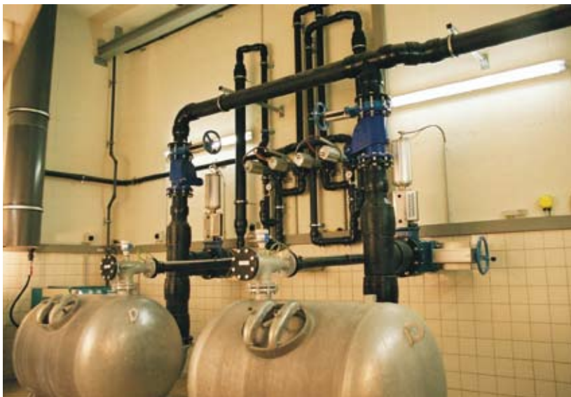
Het door A.S. Zwaans ontworpen eerste luchtpersrioolgemaal in Nederland.
